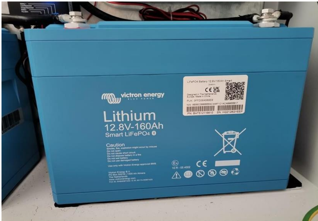
Slika 4.12. Victron Energy LiFePO baterija – 12.8 V, 160 Ah
