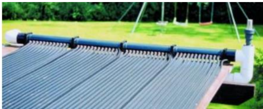
Slika 2.4. Neostakljeni apsorberi [1]
