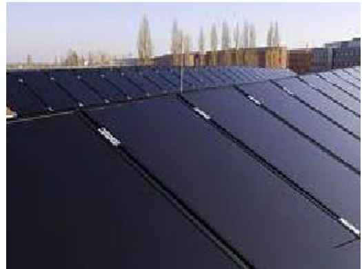
Slika 3.8, Prikazuje tankoslojni kandijev telurid fotonaponski modul [20]
