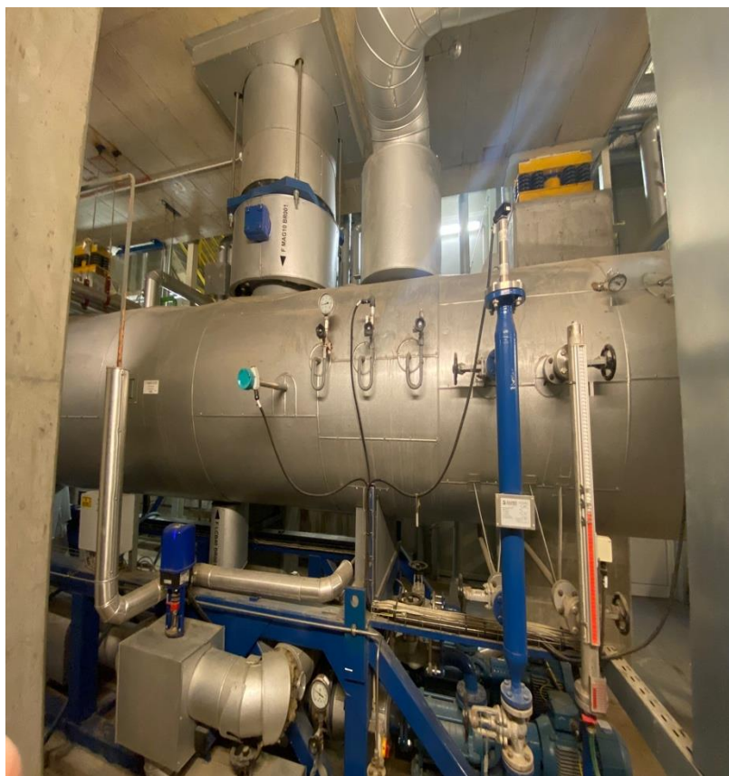
Slika 4.9. Kondenzator (fotografirano 10.siječnja 2023.)
