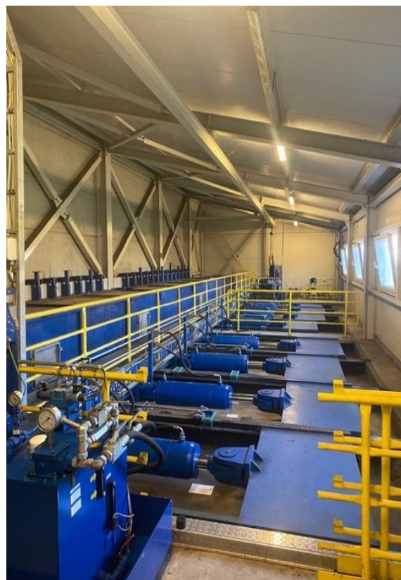
Slika 4.5. Hidraulički pokretači (fotografirano 8.lipnja 2022.)
