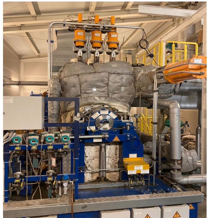
Slika 4.7. Parna turbina (fotografirano 10. siječnja 2023.)
