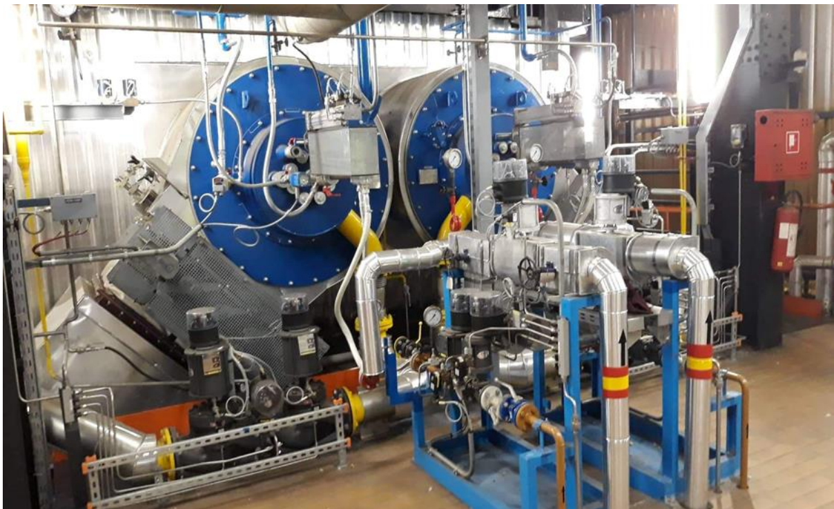
Slika 3.14.. Prikaz dva plemenika na nivou 2 (fotografirano 8.lipnja 2022.)
