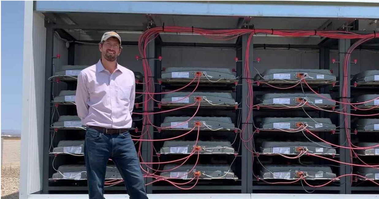
Slika 5.5. Primjena baterija u druge svrhe na primjeru iskorištenih baterija električnog automobila Nissan Leaf [37]
