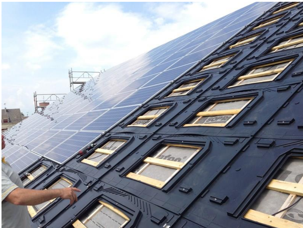
Sl.3.3. Montaža integrirane sunčane elektrane na krovu [14]
