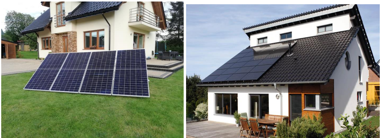
Sl.2.7. Fotonaponski moduli montirani na tlu (lijevo) i na zgradi (desno) [6,7]
