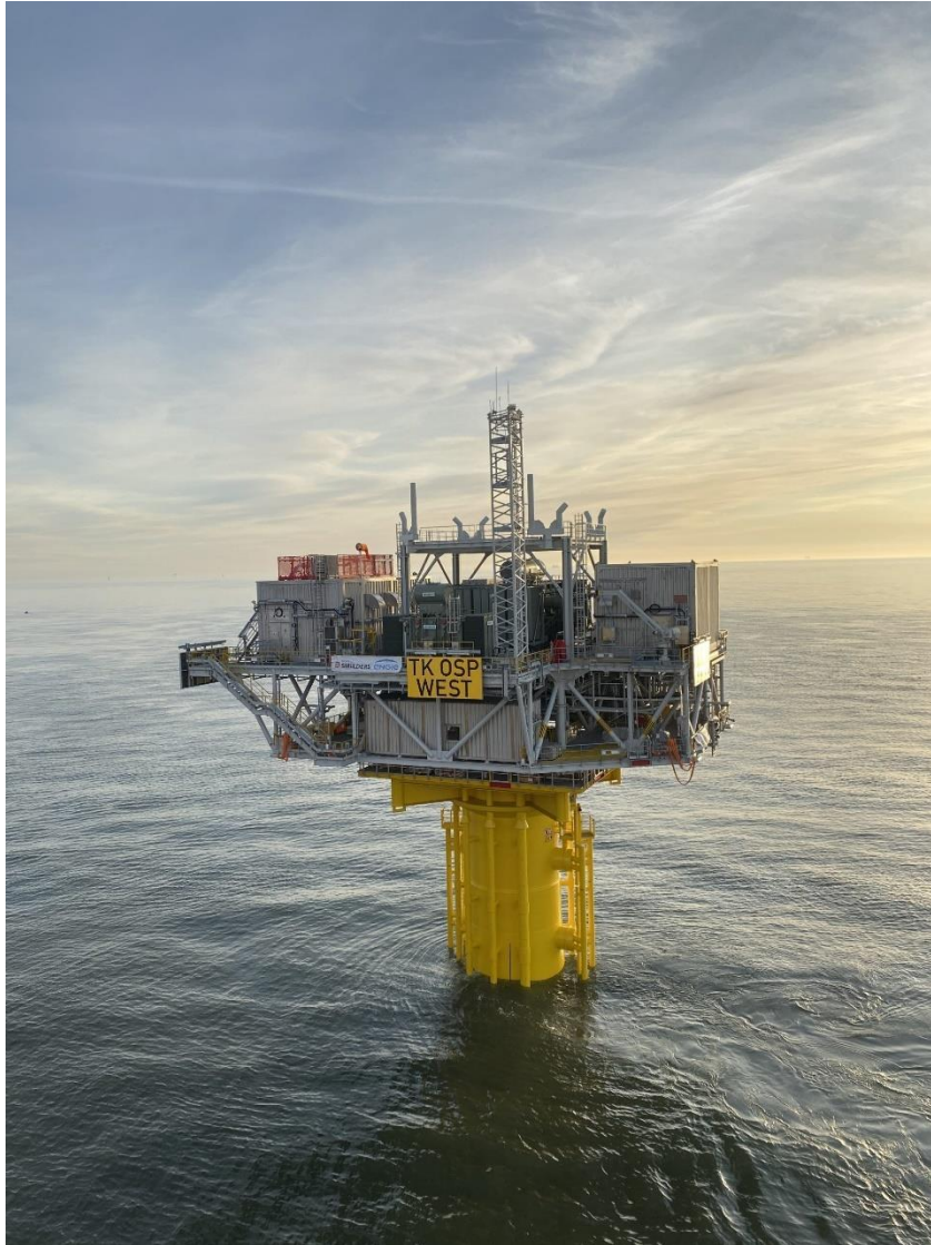
Slika 2.10 Trafostanica vjetroelektrane Triton Knoll na istočnoj obali Engleske [7]
