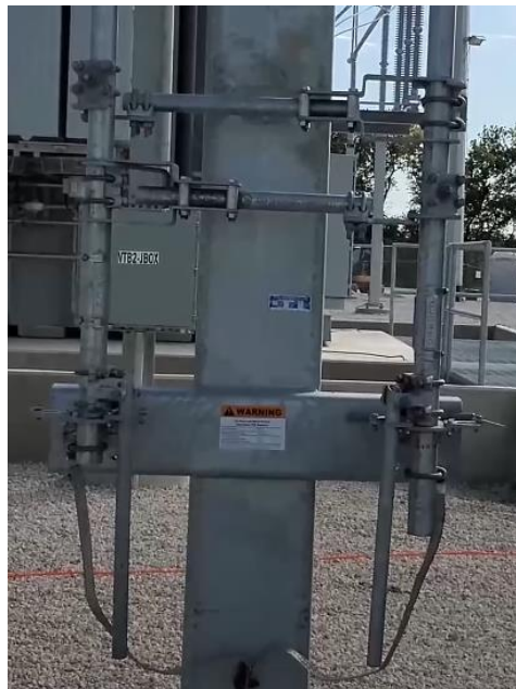
Sl. 4.1. Mehanički blokirane ručke uzemljenja [8]
