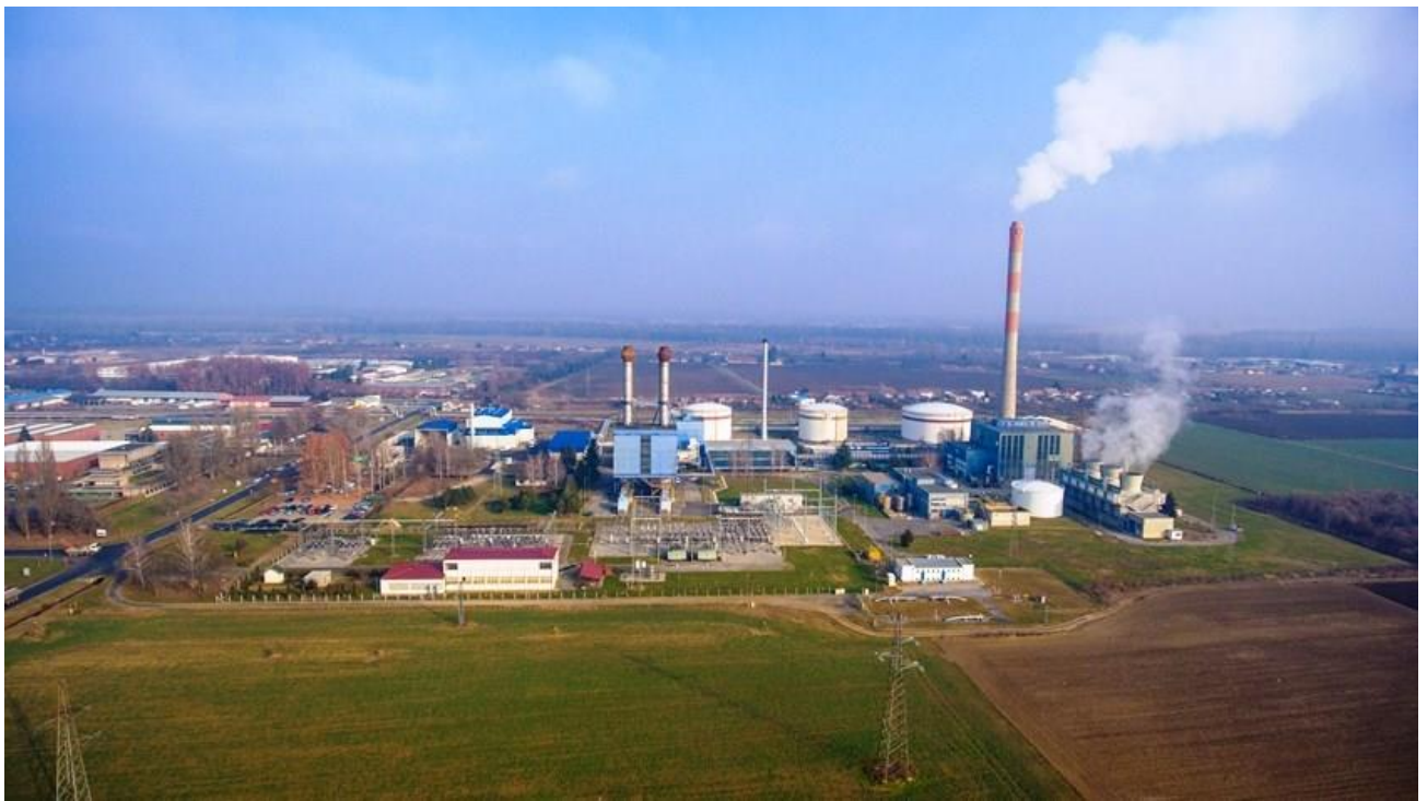
Slika 4.1. – Termoelektrana – toplana Osijek
