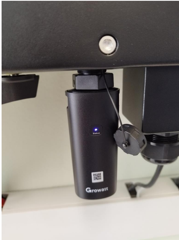
Slika 5.31. Growatt Wi-Fi dongle
