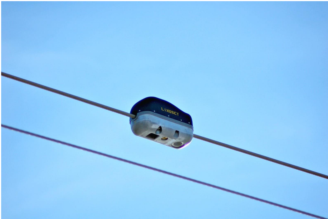
Slika 4.10. Uređaj za dinamičko procjenjivanje vodova [18]
