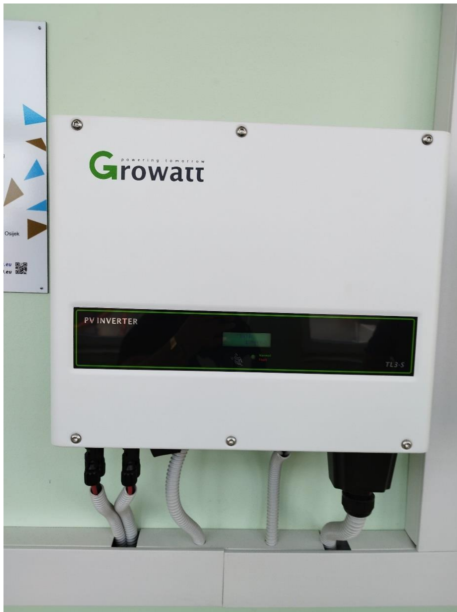
Slika 5.23. Growatt 10000 TL3-S izmjenjivač
