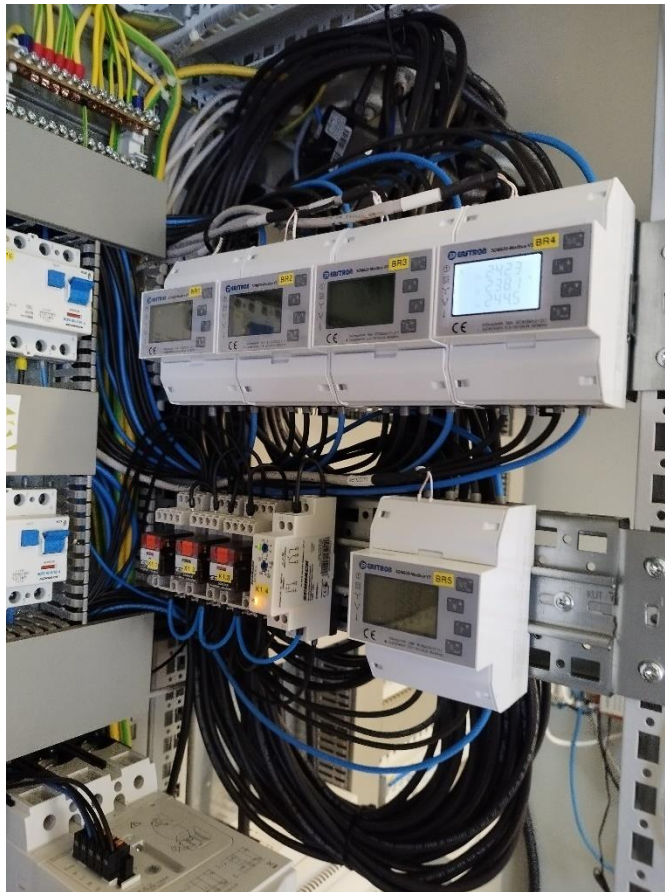
Slika 5.13. Eastron SDM630-Modbus V3
