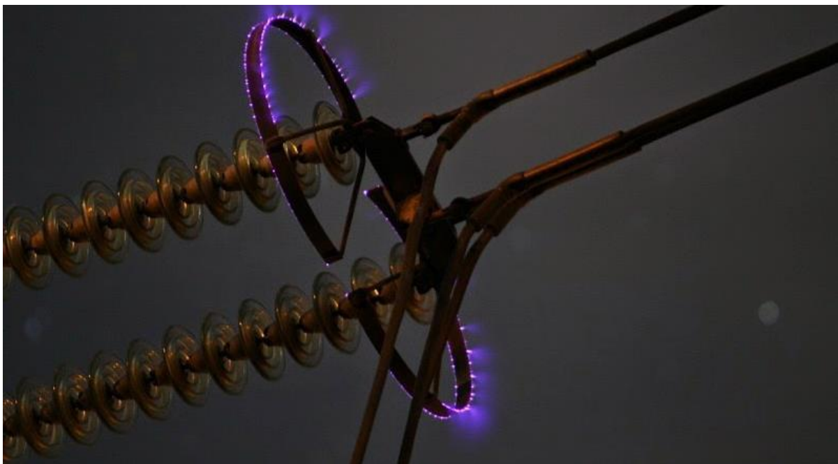
Slika 3.5. Prikaz korona efekta.[9]
