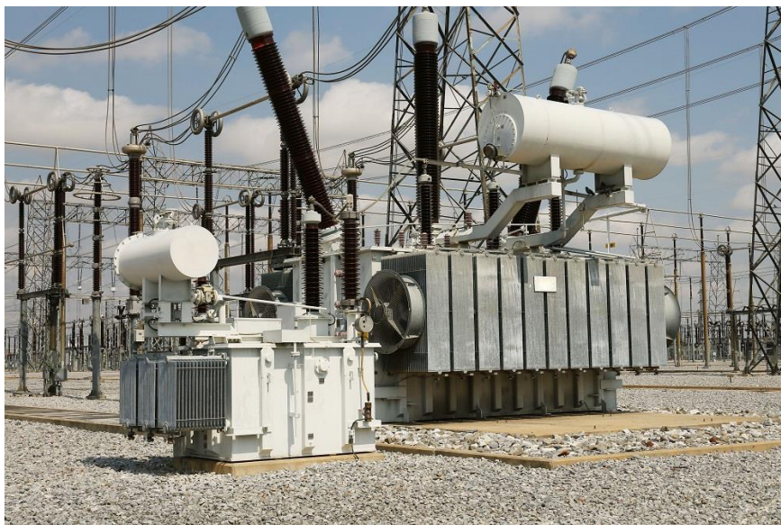
Slika 3.1. Energetske transformator [8].
