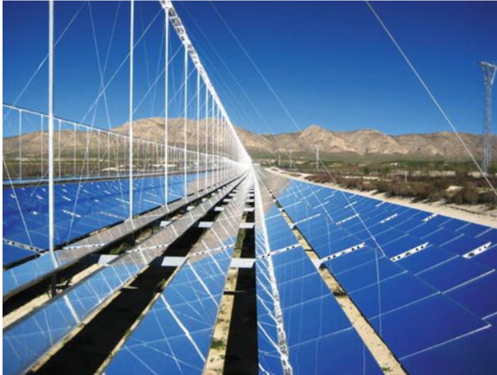
Sl. 6.2. Slika Fresnelovih kolektora[20].
