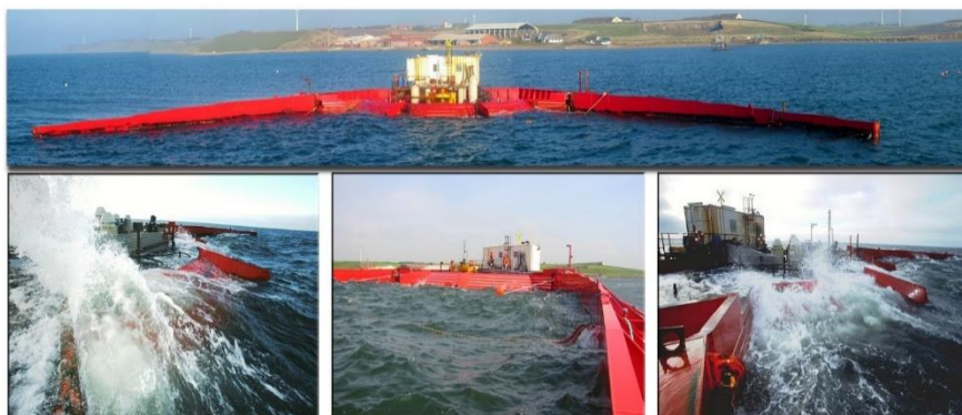
Slika 2.3 WaveDragon – primjer završnika. Reproducirano uz dopuštenje od [8]
