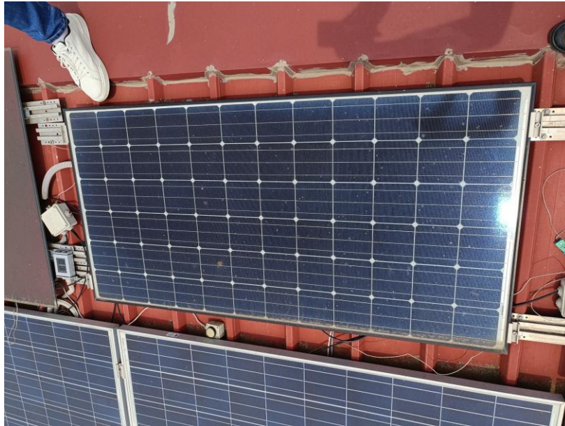
Sl. 6.20. Fotonaponski modul PANASONIC VBHN240SE10
