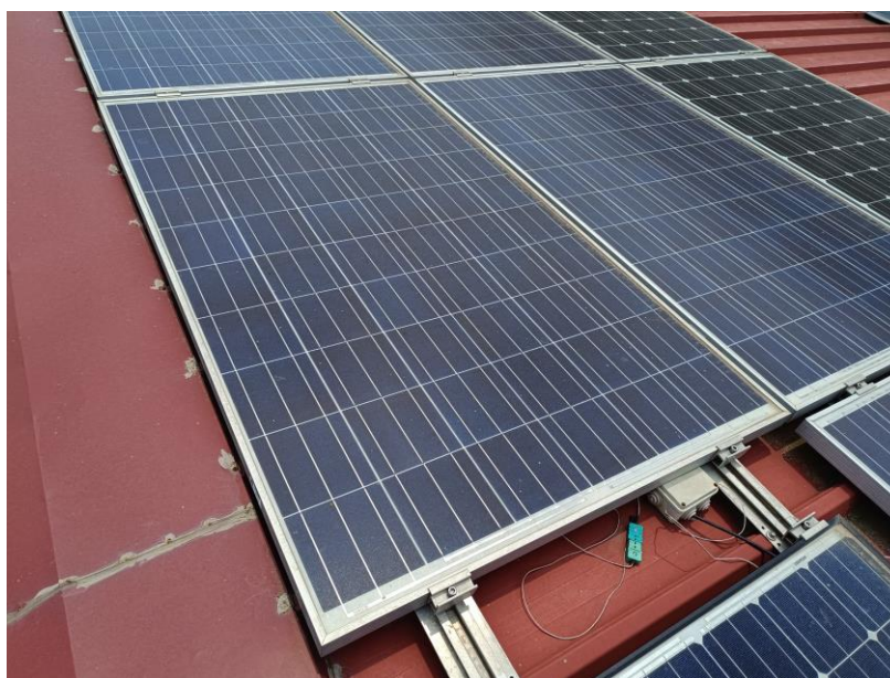
Sl. 6.10. Fotonaponski modul BISOL BMU
