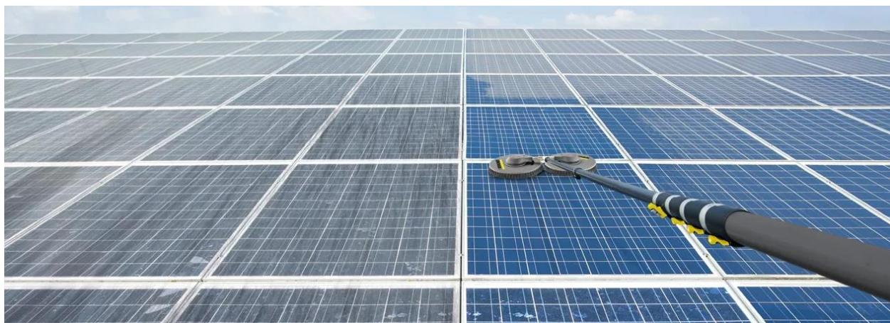
Slika 4.3.1. Održavanje solarnih panela [16]
