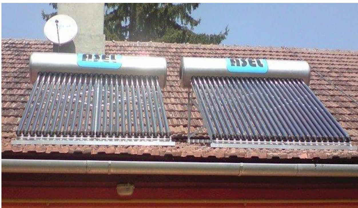
Slika 2.3.1. Primjer solarnih kolektora [2]
