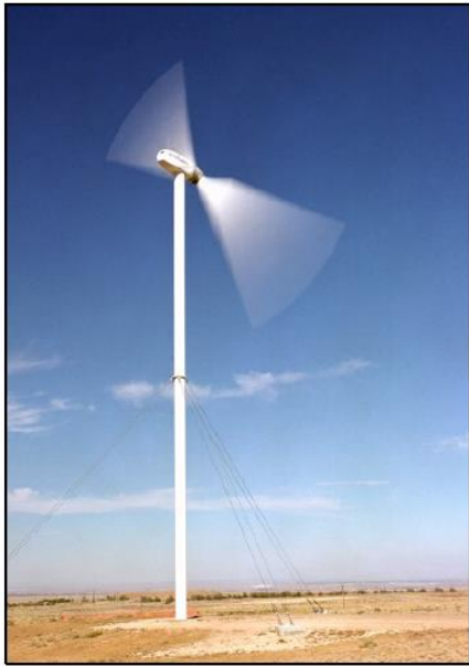
Slika 3.6. Izvedba sa stupom ispred lopatica i izvedba sa stupom iza lopatica [6]
