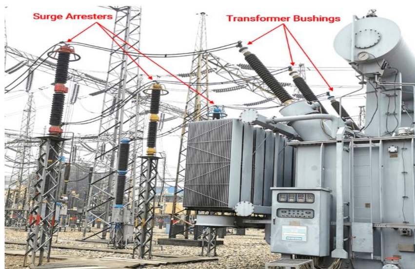
Slika 4.3. Odvodnici prenapona [22]
