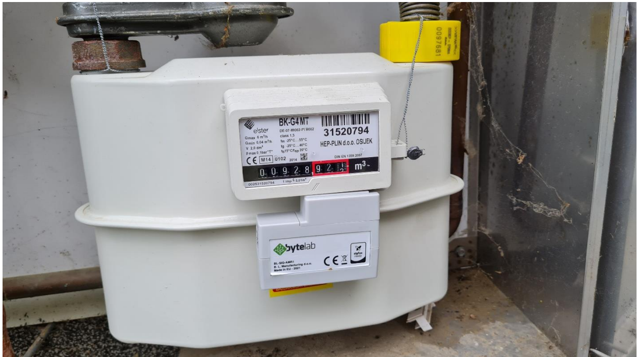
Slika 4.1: Modul (senzor) priključen za membranski plinomjer G4 za SigFox mrežu, distribucijska mreža HEP-Plin
