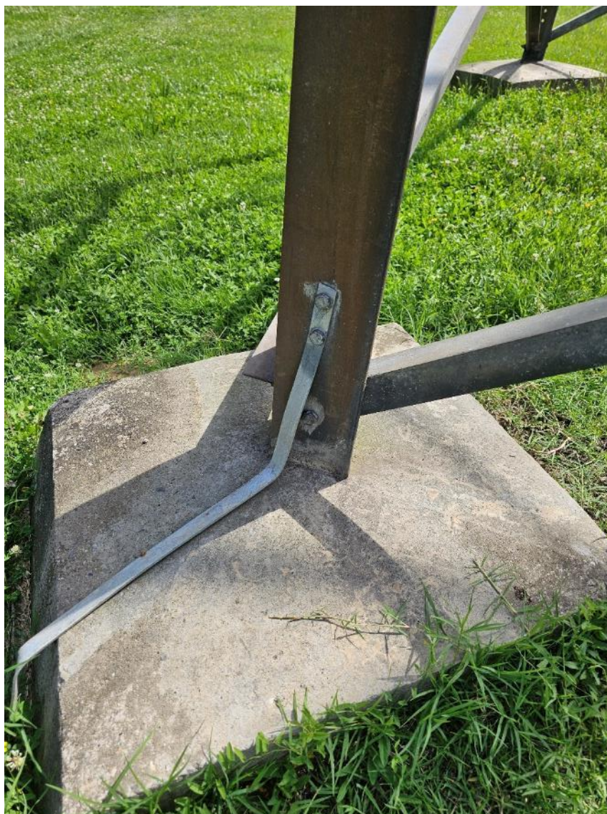
Slika 5.8. Mjesto odvajanja uzemljivača od stupa i zaštitnog užeta
