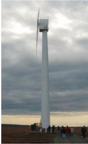
Slika 3.1 Turbina niz vjetar [11]
