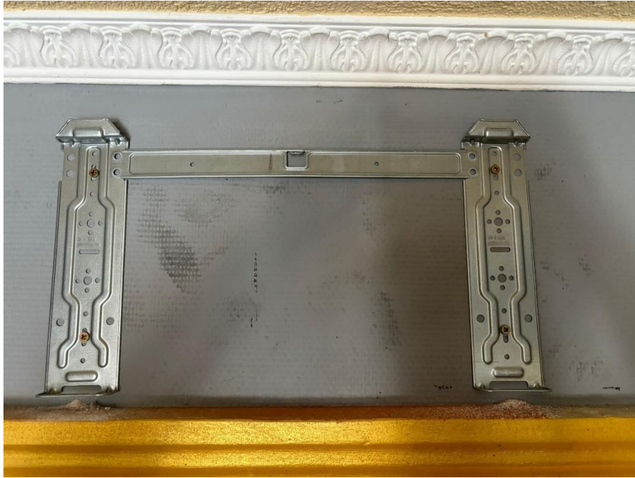
Slika 6.1. Postavljanje montažne ploče za unutarnju jedinicu.
