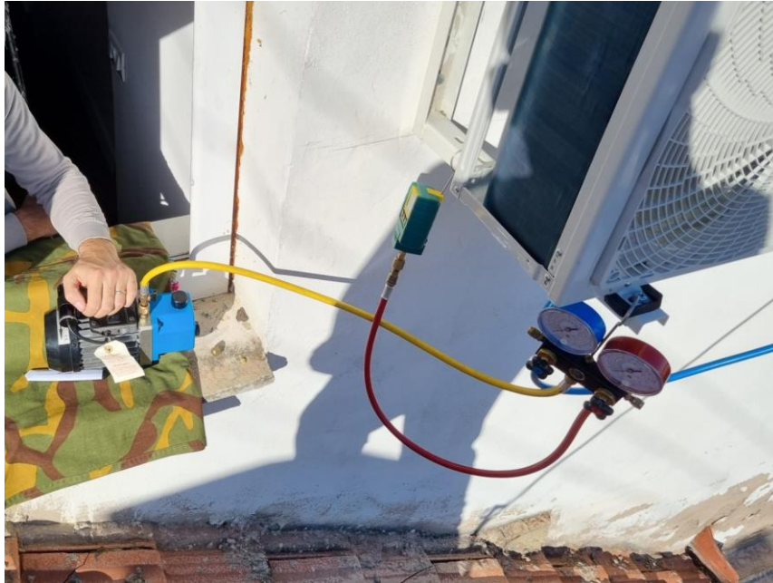
Slika 6.10. Prikaz vakuumiranja sustava [66].
