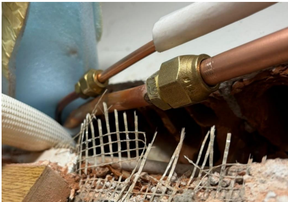
Slika 6.5. Spajanje bakrenih cijevi.
