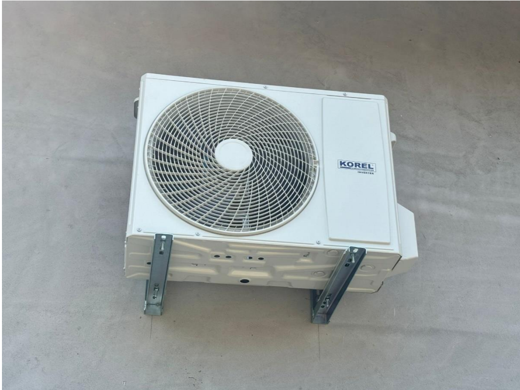
Slika 6.7. Montaža vanjske jedinice.
