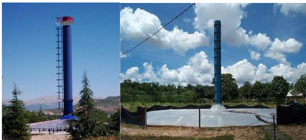
Sl. 2.3. Izgrađeni solarni dimnjaci za istraživanje [5]
