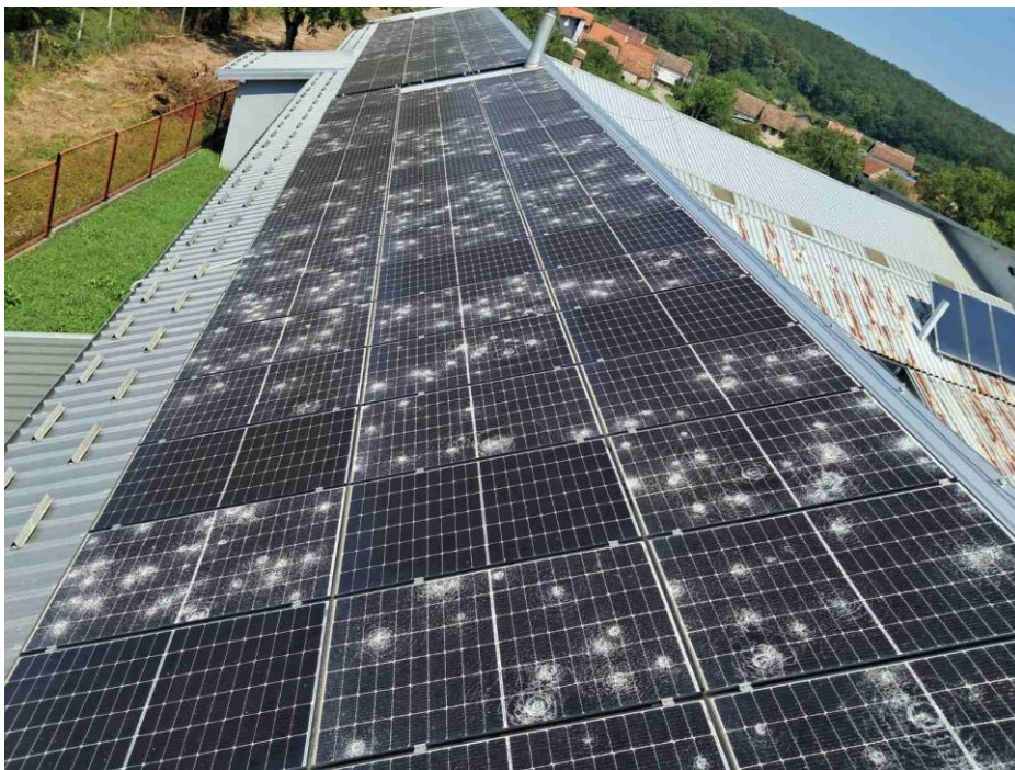
Sl. 3.2. Šteta nastala prilikom udara leda
