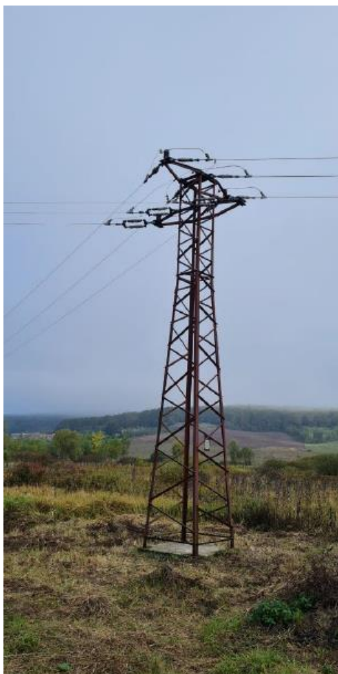
Slika 5-1 Stup prije postavljanja daljinski upravljive naprave
