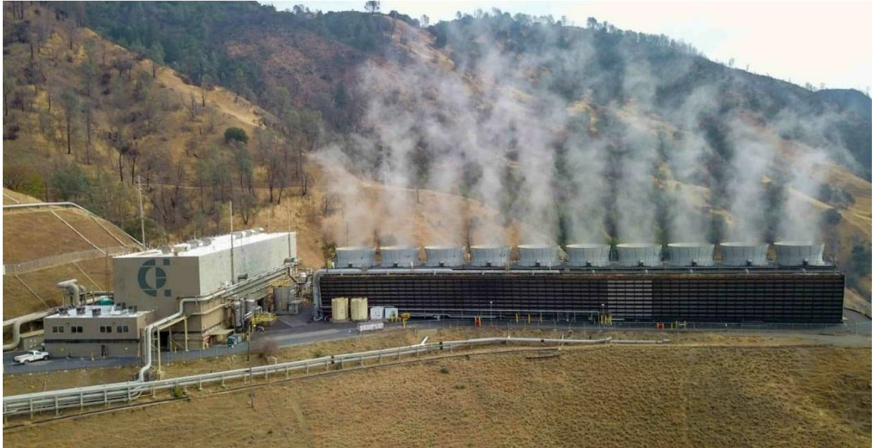
Slika 2.8. Geotermalno postrojenje Geysers, SAD [34]
