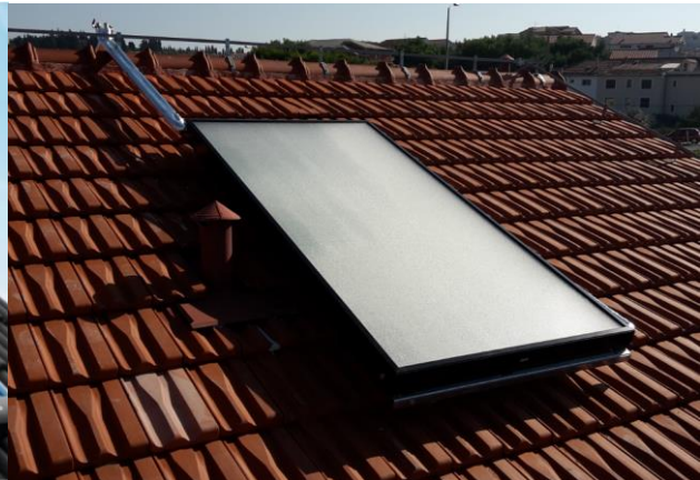
Slika 2.3.3. Pločasti kolektor [16]
