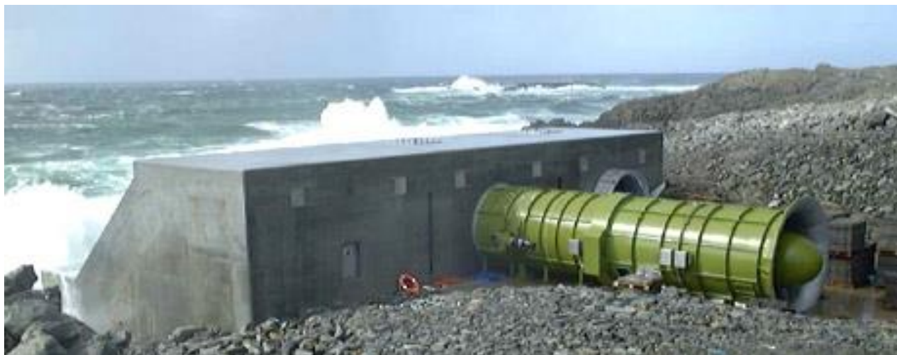
Slika 2.2.1. Postrojenje na morske valove Limpet u Škotskoj. [11]
