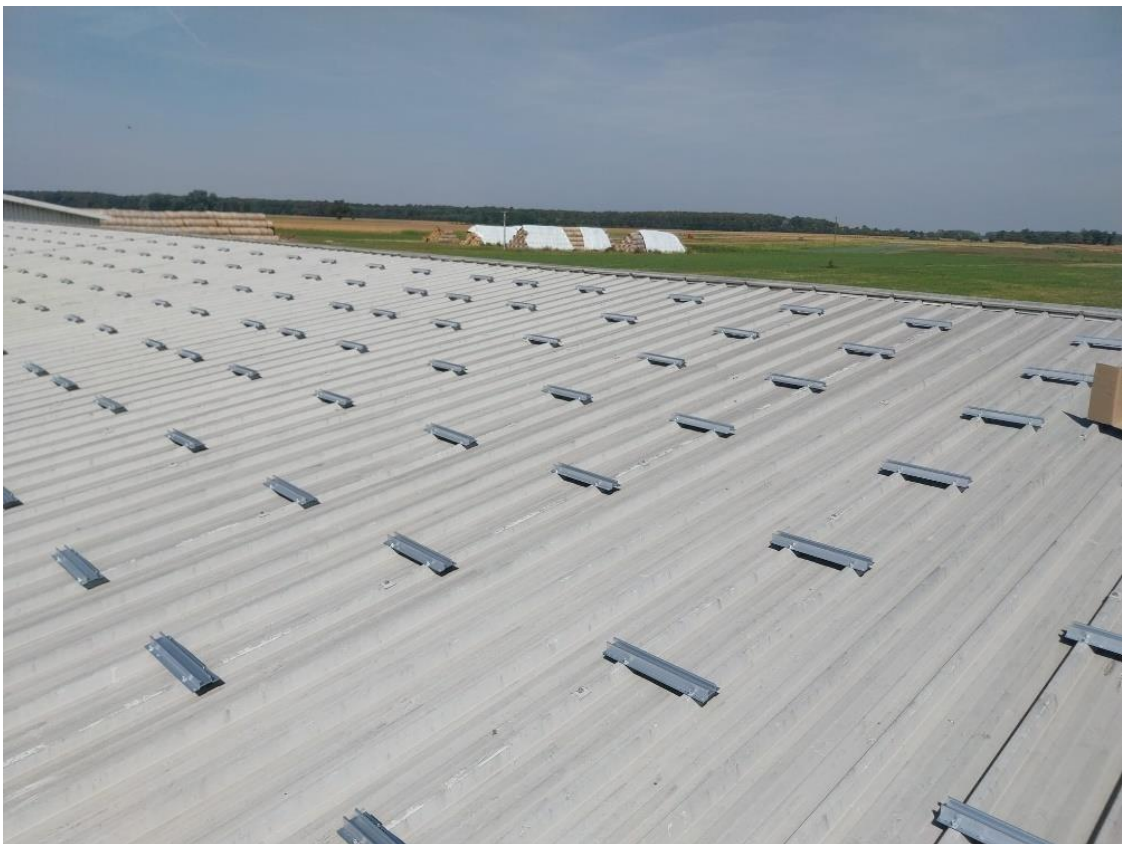
Slika 3.6 Prikaz postavljene konstrukcije za trapezni lim
