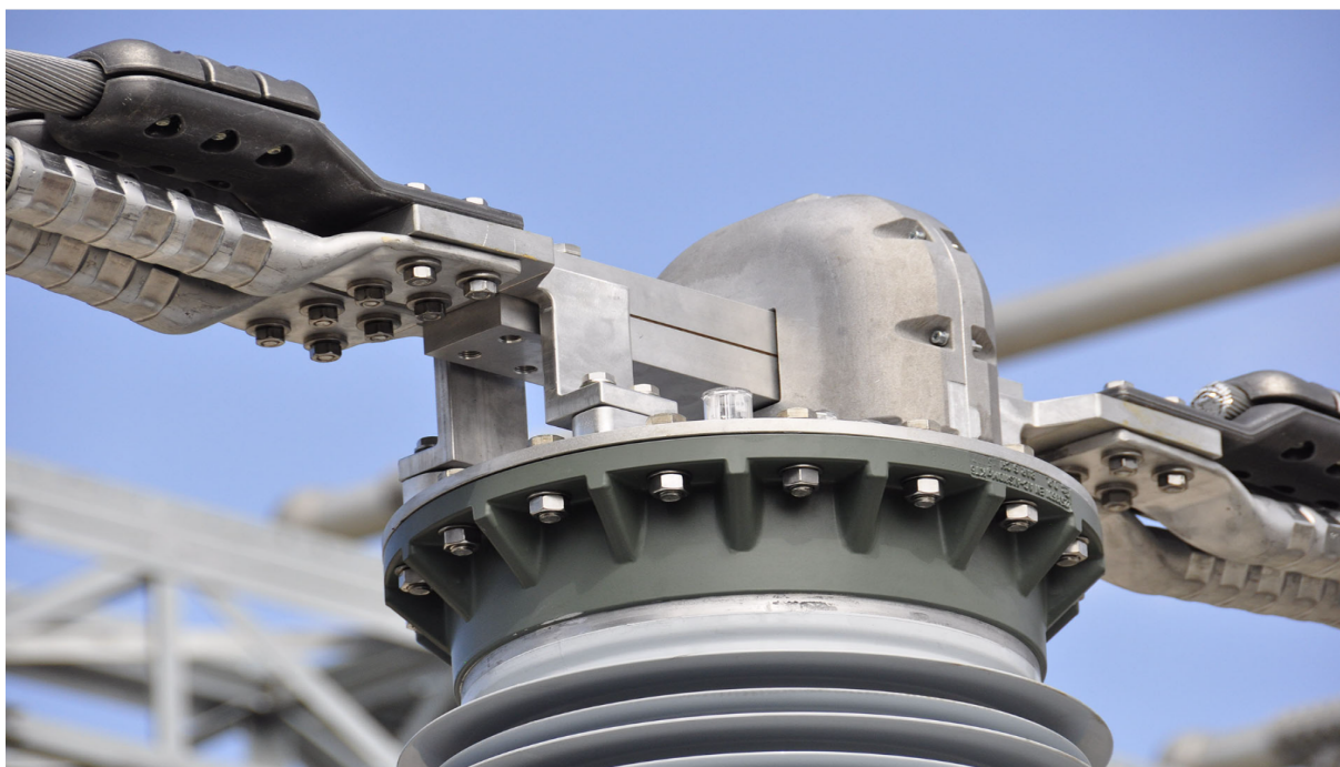
Slika 5.1.: Optički strujni mjerni transformator Trench [7]
