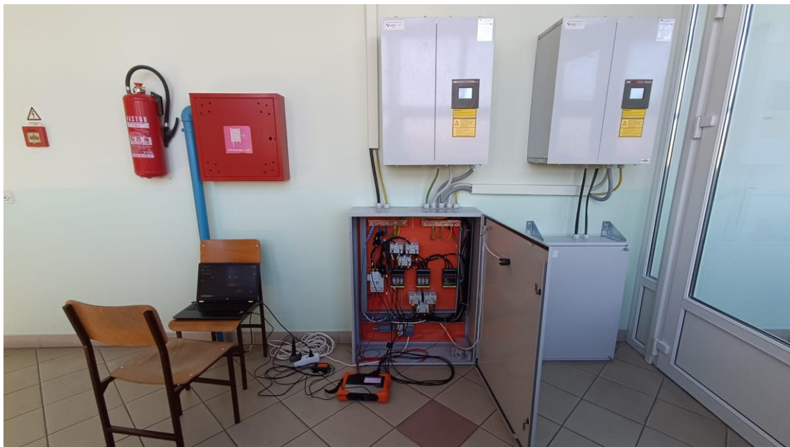
Slika 6.1. Aktivni filter harmonika (lijevo, gore), generator harmonika (desno, gore) i razvodni ormar s priključenim mrežnim analizatorom
