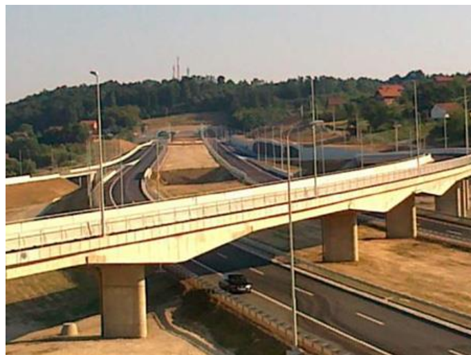
Sl. 3.2. Stupovi javne rasvjete, [7].
