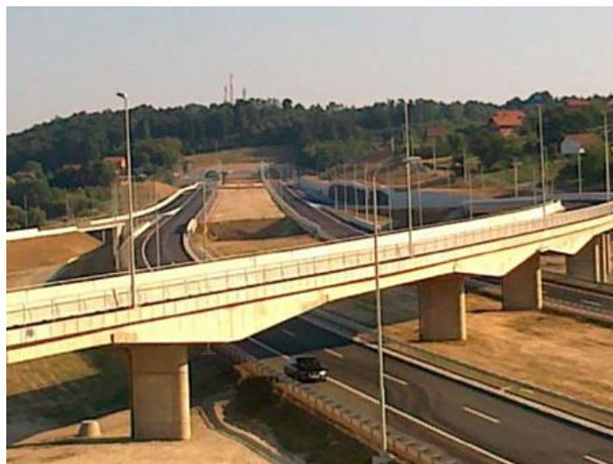
Sl. 3.2. Stupovi javne rasvjete, [7].
