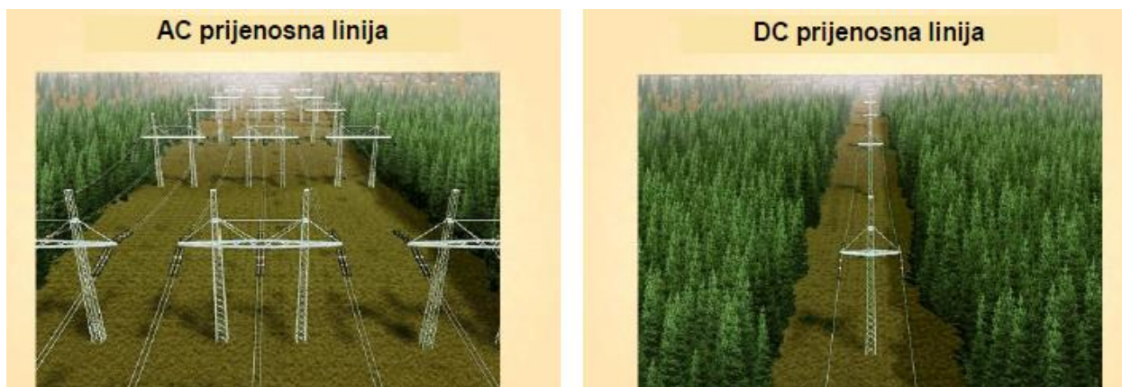
Slika 3.14. Izgled AC i DC prijenosne linije[5]
