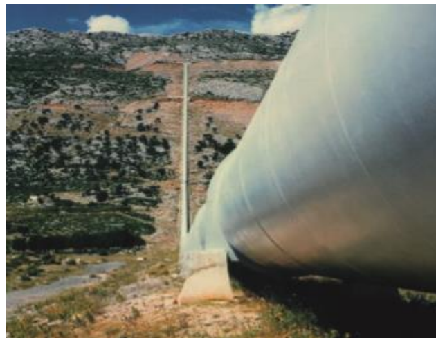
Slika 4.5. Čelični tlačni cjevovod RHE Velebit
