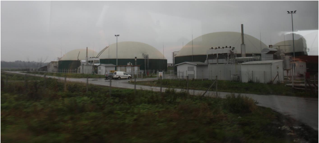
Slika 3.8. Bioplinska elektrana Mala Branjevina.
