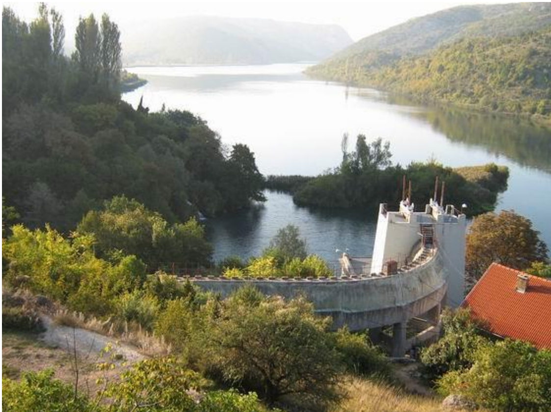
Slika 3.3. Mala hidroelektrana Roški slap nazivne snage 1.764MW [9]
