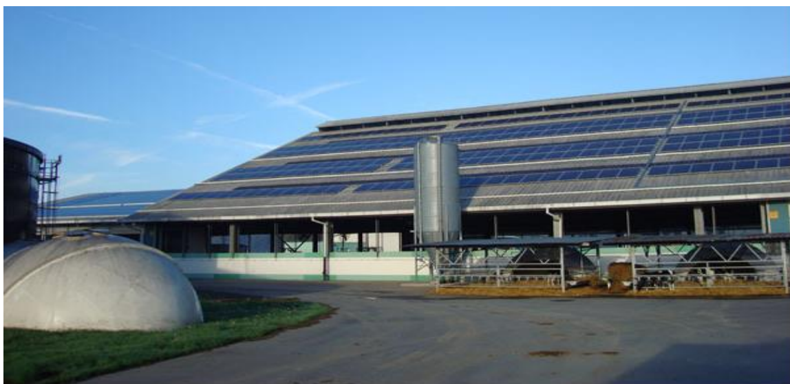
Slika 3.4. Fotonaponska elektrana Topolik.
