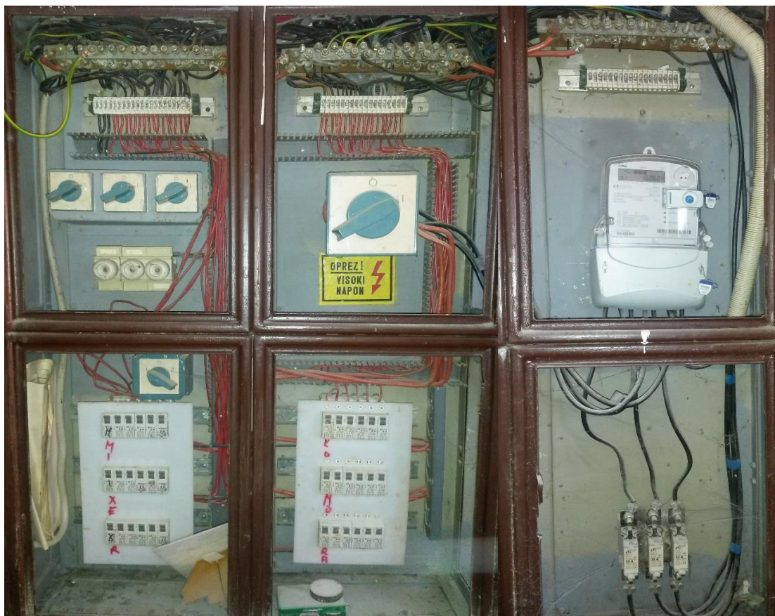
Slika 4.32. Razvodni ormar
