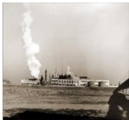
Slika 2.2. Izgled tvornice izvana (preuzeto iz [1])
