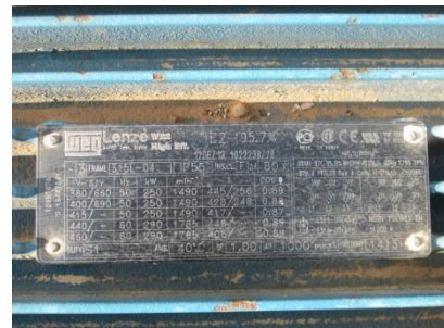
Slika 3.65. Pločica motora odsisnog ventilatora
