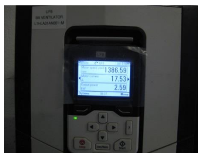
Slik 3.52. Regulator za BA ventilator
