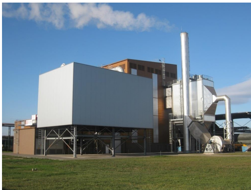
Slika 2.3. Elektrana na biomasu " Slavonija OIE"
