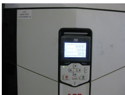
Slika 3.51. Regulator za usisni ventilator
