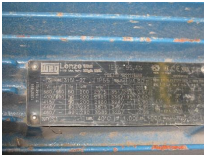
Slika 3.66. Pločica motora usisnog ventilatora
