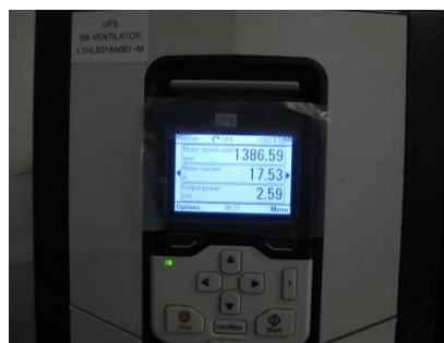
Slik 3.52. Regulator za BA ventilator
