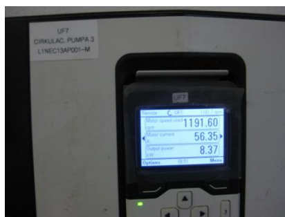
Slika 3.58. Regulator za za cirkulac. pumpu 3
