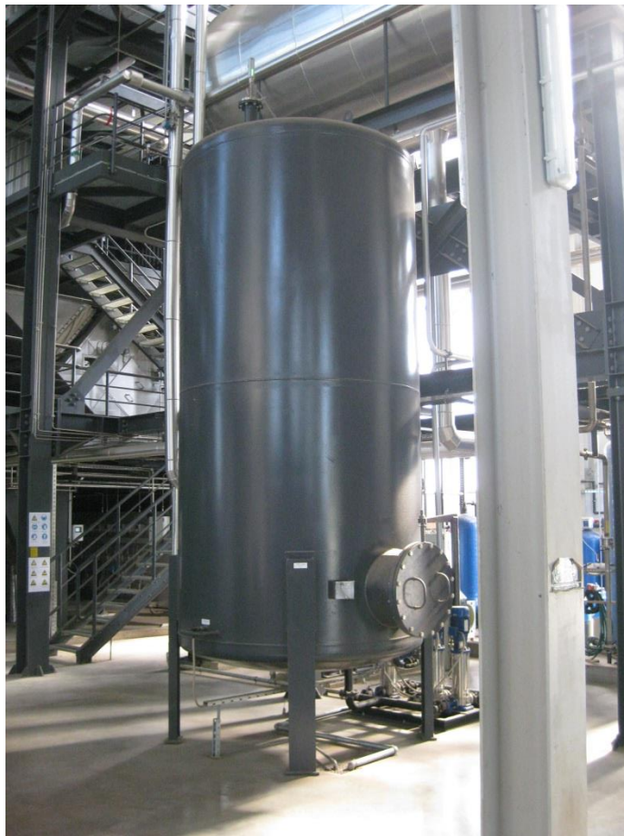
Slika 3.38. Napojni spremnik
