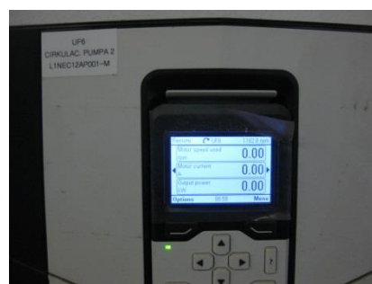
Slika 3.57. Regulator za za cirkulac. pumpu 2
