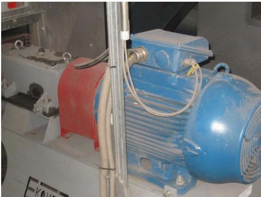
Slika 3.45. Motor BA ventilatora
