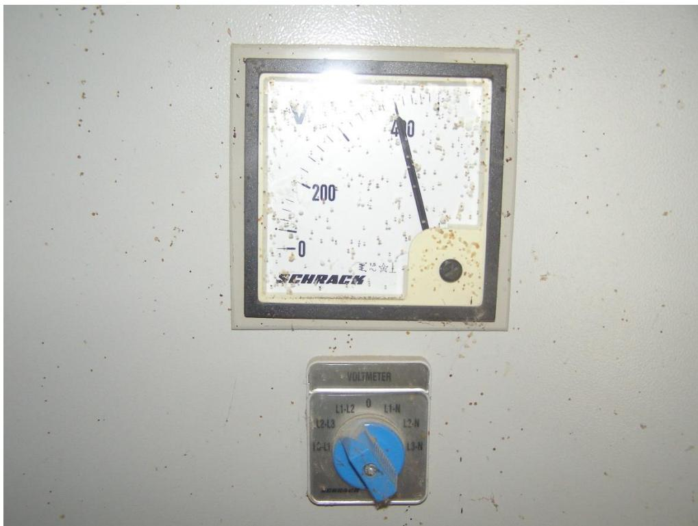
Slika 5.18. Mjerni instrument za napon
