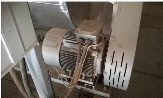
Slika 4.24. Asinkroni motor koji upuhuje zrak
