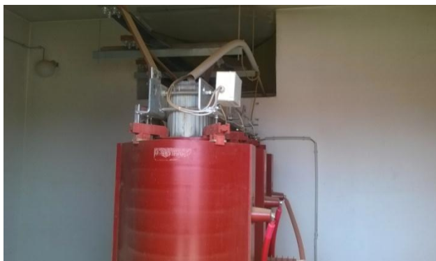
Slika 5.1. 10/0,4 kV transformator
