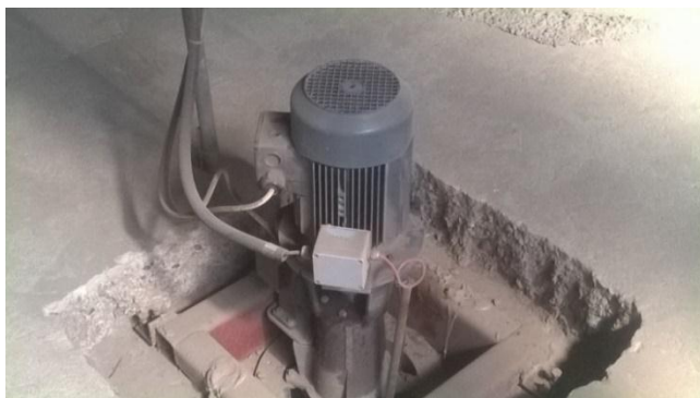
Slika 4.19. Asinkroni motor za upuhivanje toplog zraka
