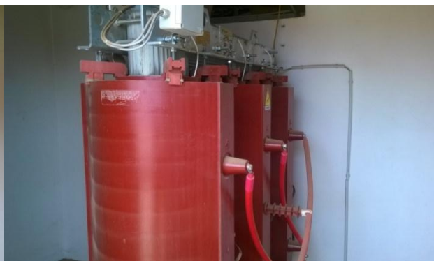
Slika 5.2. 10/0,4 kV transformator
