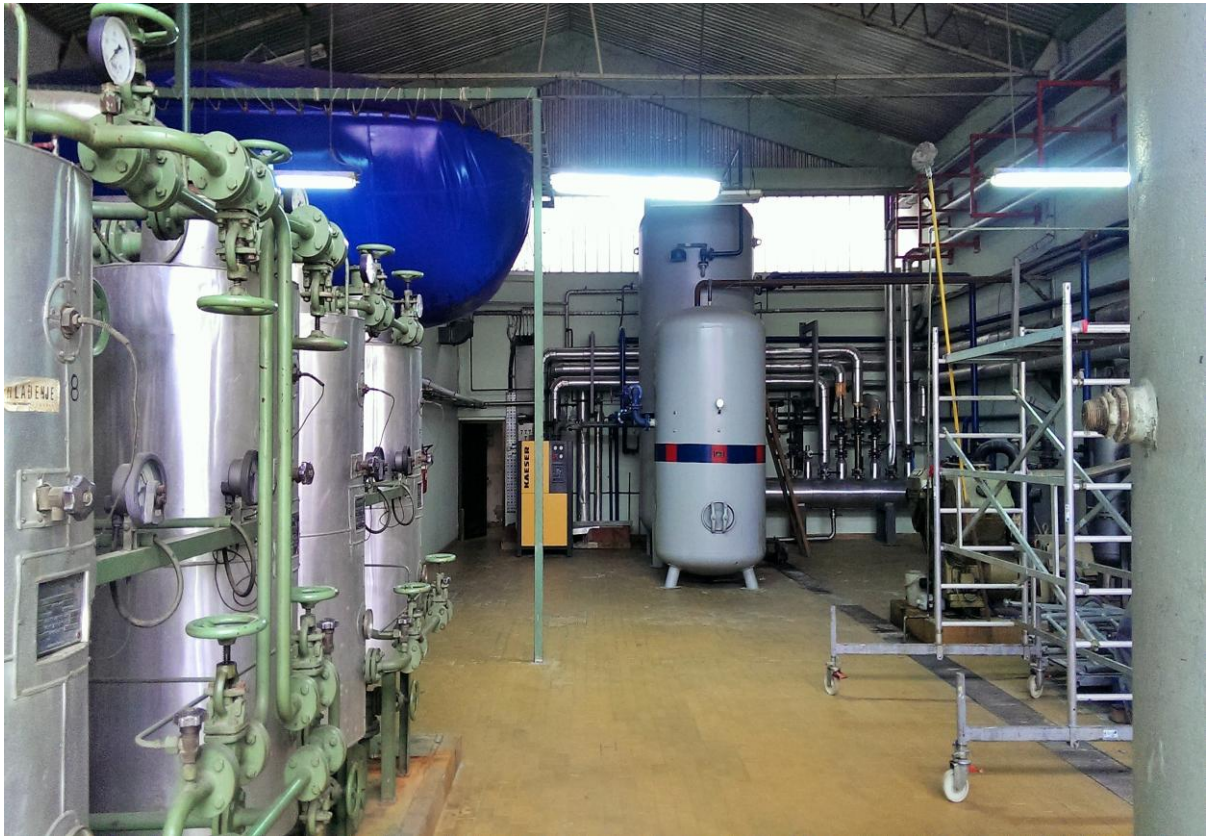
Slika 4.4. Pogon za kružni proces ugljikovog dioksida (CO 2 )
