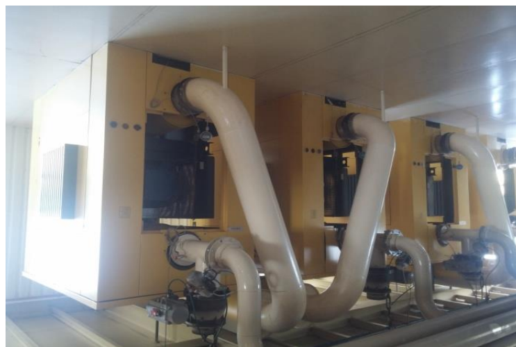
Slika 3.6. Prikaz motora za stvaranje vaakuma
