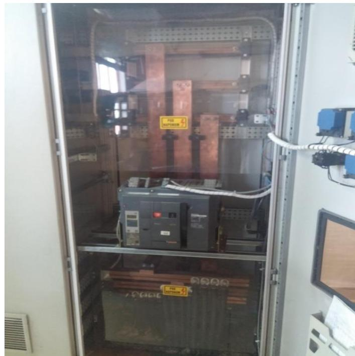
**Slika 2.5.** Prikaz priključnog ormara transformatora i njegove sklopke
