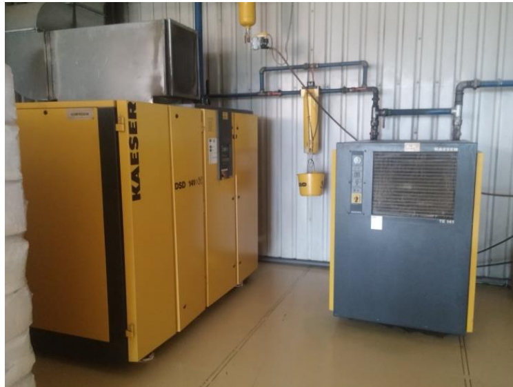
Slika 3.7. Prikaz kompresora
