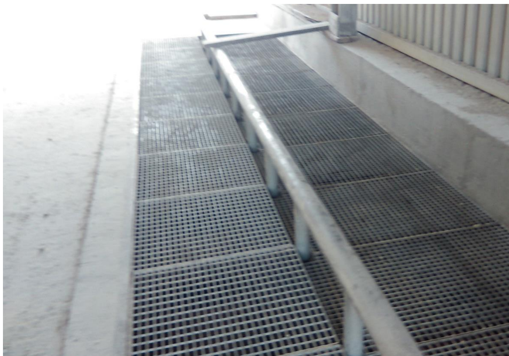
Slika 2.6. Usipni koš za istovar žitarice
