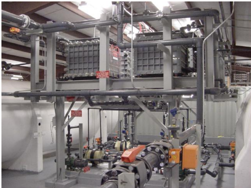
Sl. 2.8. Slogovi ćelija, pumpe i ventili VRB sustava u Castle Valley (Utah, SAD) [12]
