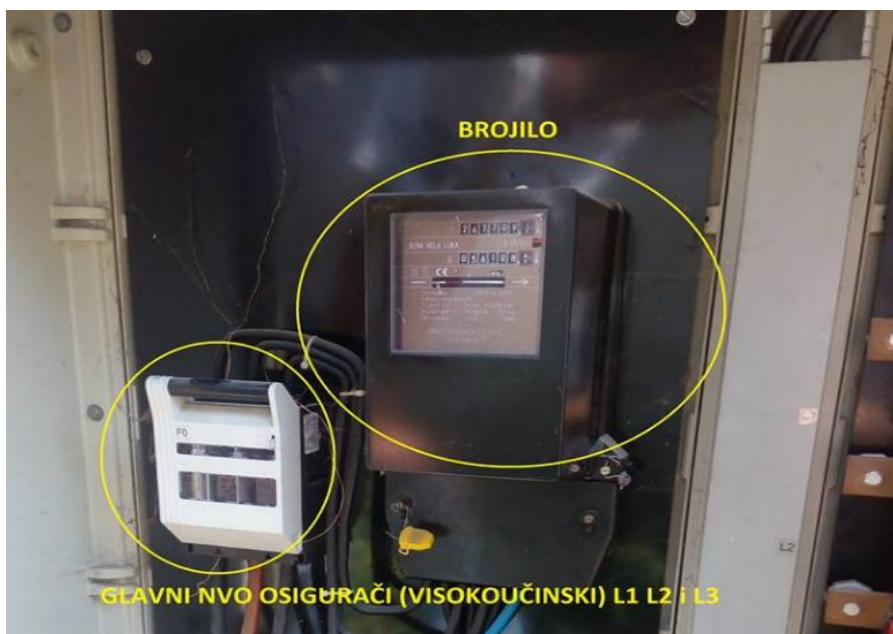
Slika 4.2.8. Sadržaj ormara javne rasvjete (OCR).
