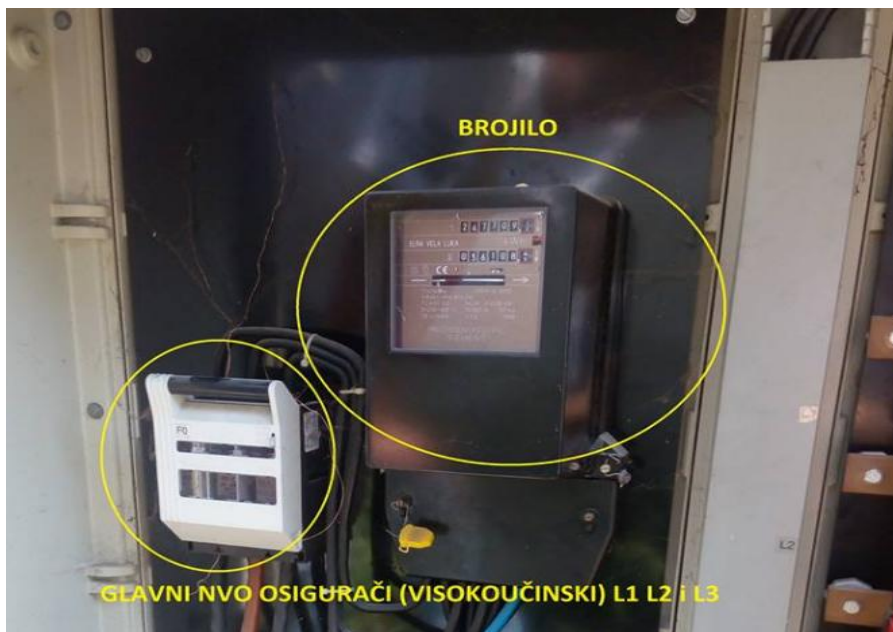
Slika 4.2.8. Sadržaj ormara javne rasvjete (OCR).
