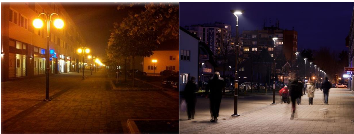
Slika 6.1.7.1. Slika rasvjete šetnice prije i nakon rekonstrukcije [8]
