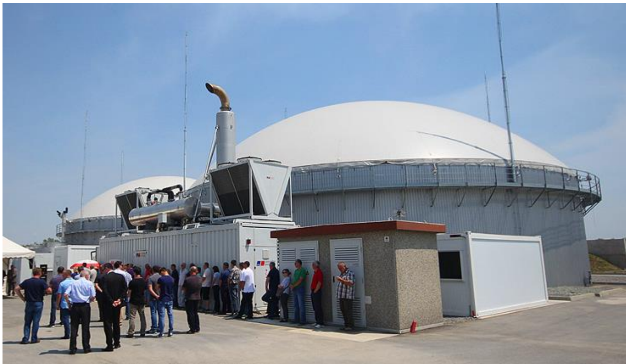
Slika 9. Bioplinska elektrana Bionardo – Crnac [9]
