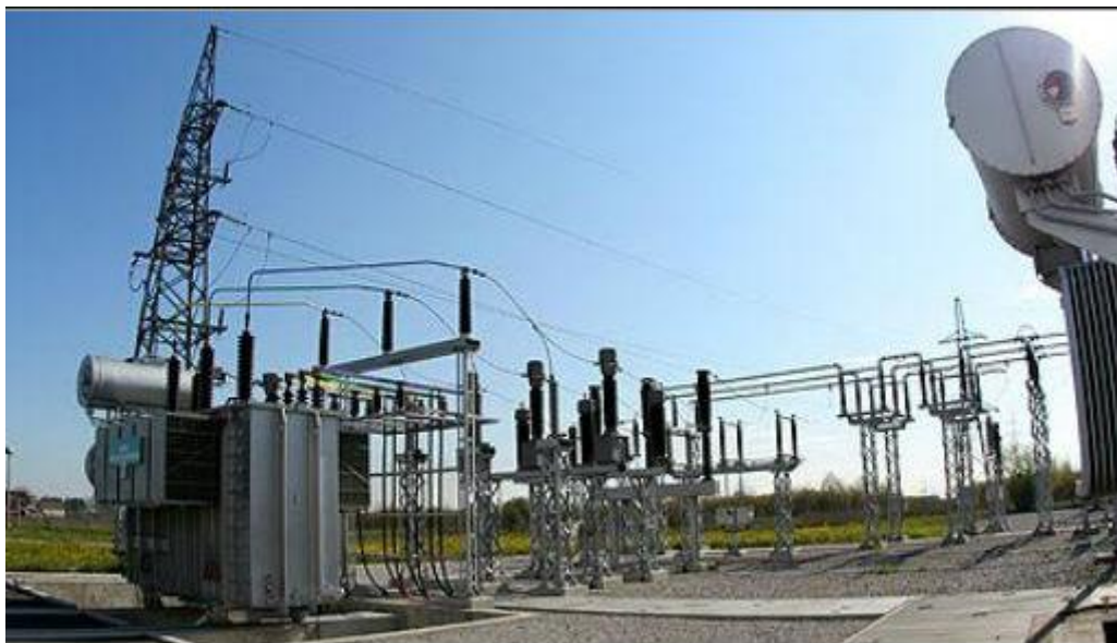
Slika 5. Rasklopno postrojenje [5]
