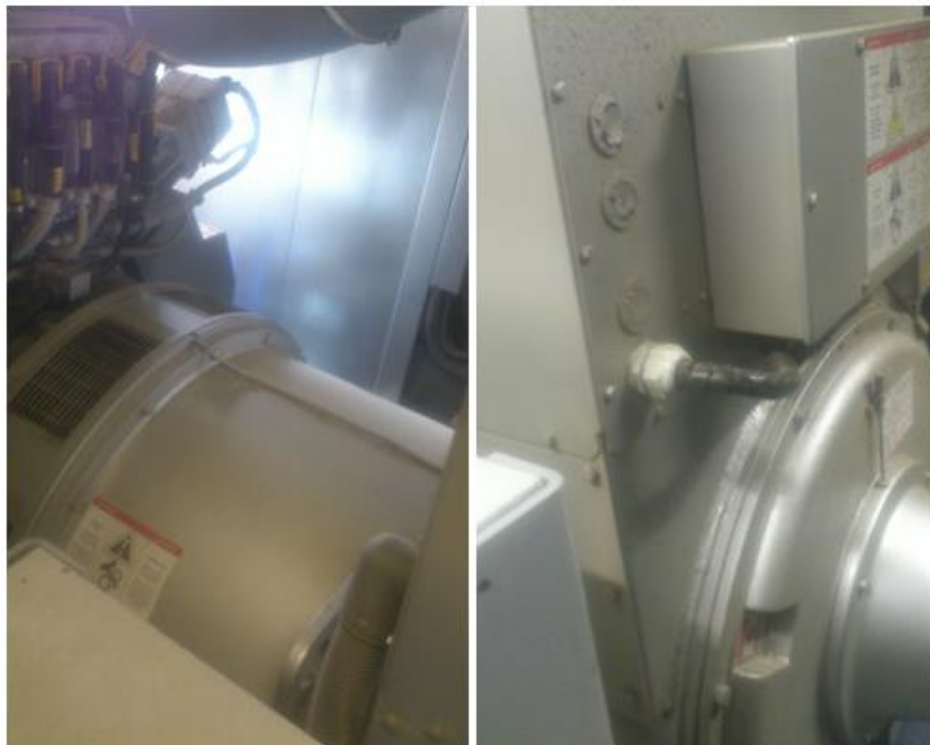
Slika 1. Stamford sinkroni generator[2]
