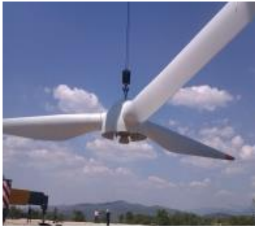
Slika 4.7: Lopatice vjetroelektrane K80 2.5 MW
