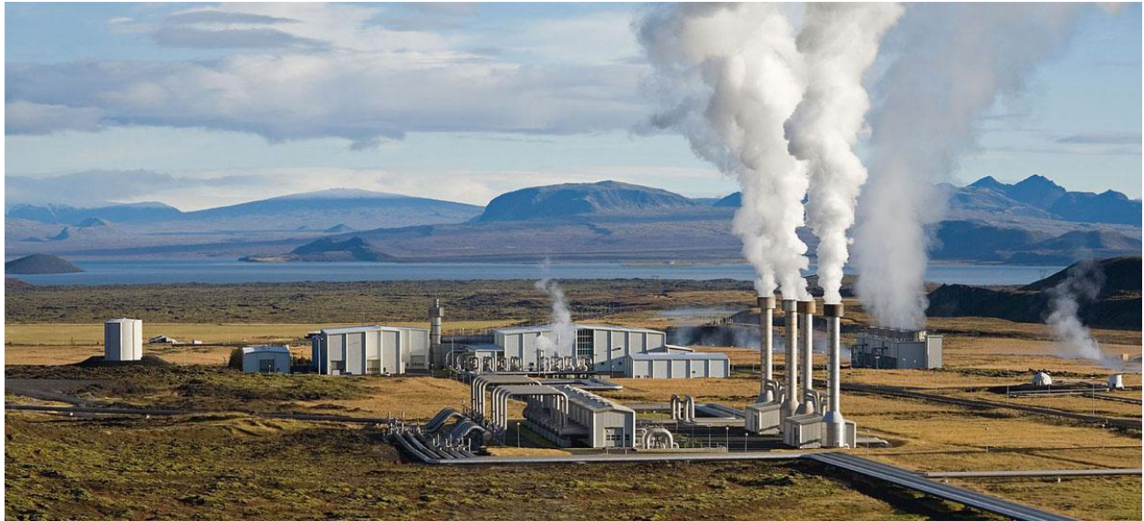
Sl. 4.1 Geotermalna elektrana Nesjavellir, Island [5]
