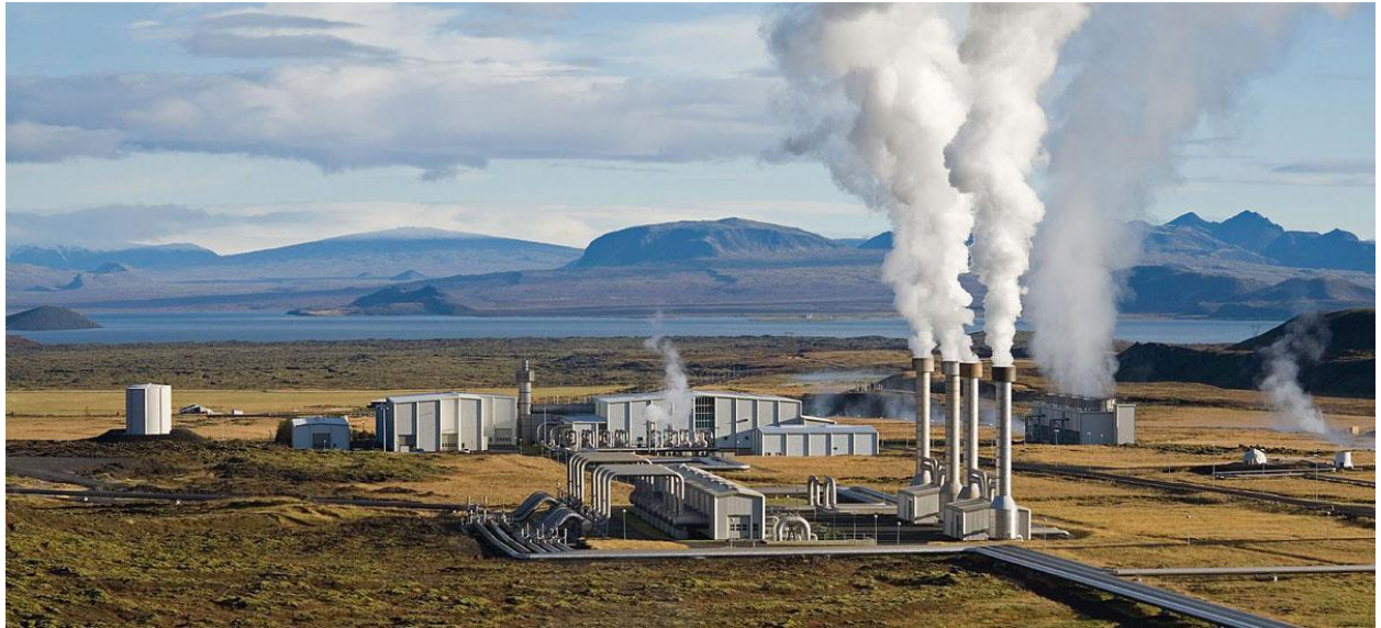
Sl. 4.1 Geotermalna elektrana Nesjavellir, Island [5]
