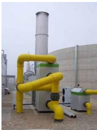
Slika 2.16. Izgled baklje za izgaranje bioplina [4]
