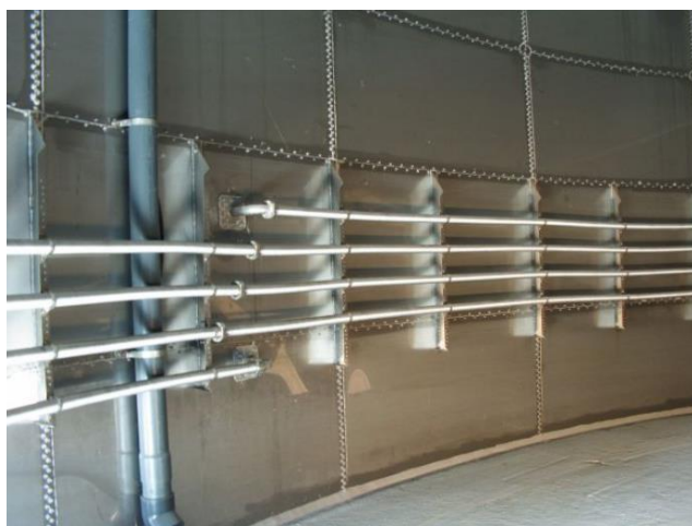
Slika 2.10. Cijevi za grijanje unutar fermentora [4]
