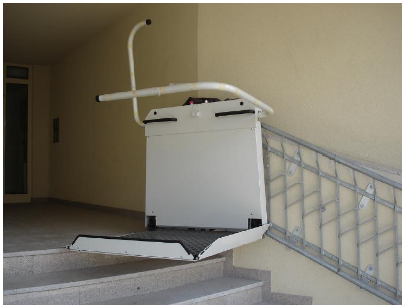
Slika 3.1. Primjer platforme dizala za osobe s invaliditetom [4].
