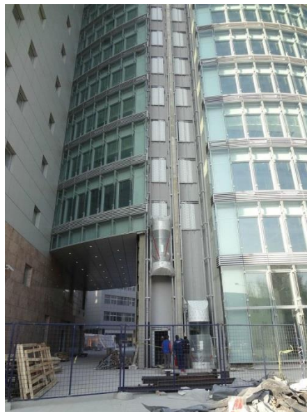
Slika 3.7. Primjer panoramskog dizala na zgradi Eurodoma u Osijeku.
